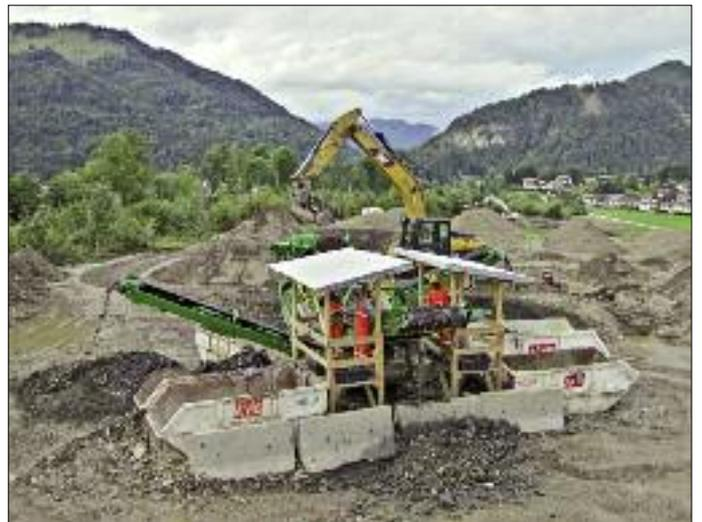
Mittlerweile sind zwei Drittel des Volumens (gesamt knapp 50.000 m<sup>3</sup>, dies entspricht einem mittelgroßen Öltanker) ausgebaggert, gesiebt und sämtliche Teile über Handtellergröße händisch
